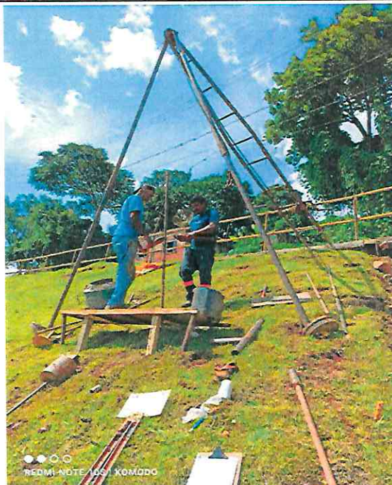
Descrição do serviço: SONDAGEM NO TALUDE NA ENTRADA DA SEMOBI - SPT - 01
