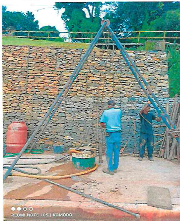
Descrição do serviço: SONDAGEM NO TALUDE NA ENTRADA DA SEMOBI - SPT - 02
